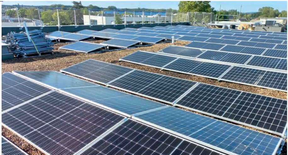
Illustration 20 Installation de panneaux solaires sur le Collège d'Avoine (CD 37, STENER, 2023)
