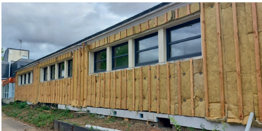
Illustration 19 Isolation par l'extérieure du Collège de Neuvy-le-Roi (CD 37, STENER, 2022)
