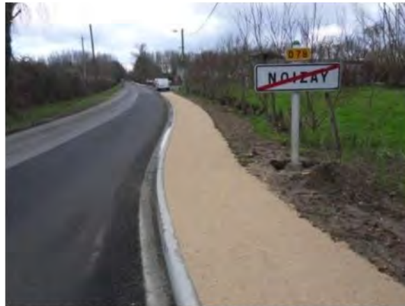
RD78 à Noizay Cheminement piéton vers la gare
