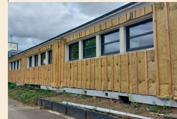
Isolation par l'extérieur du collège de Neuvy-le-Roi. (CD 37, 2022)
